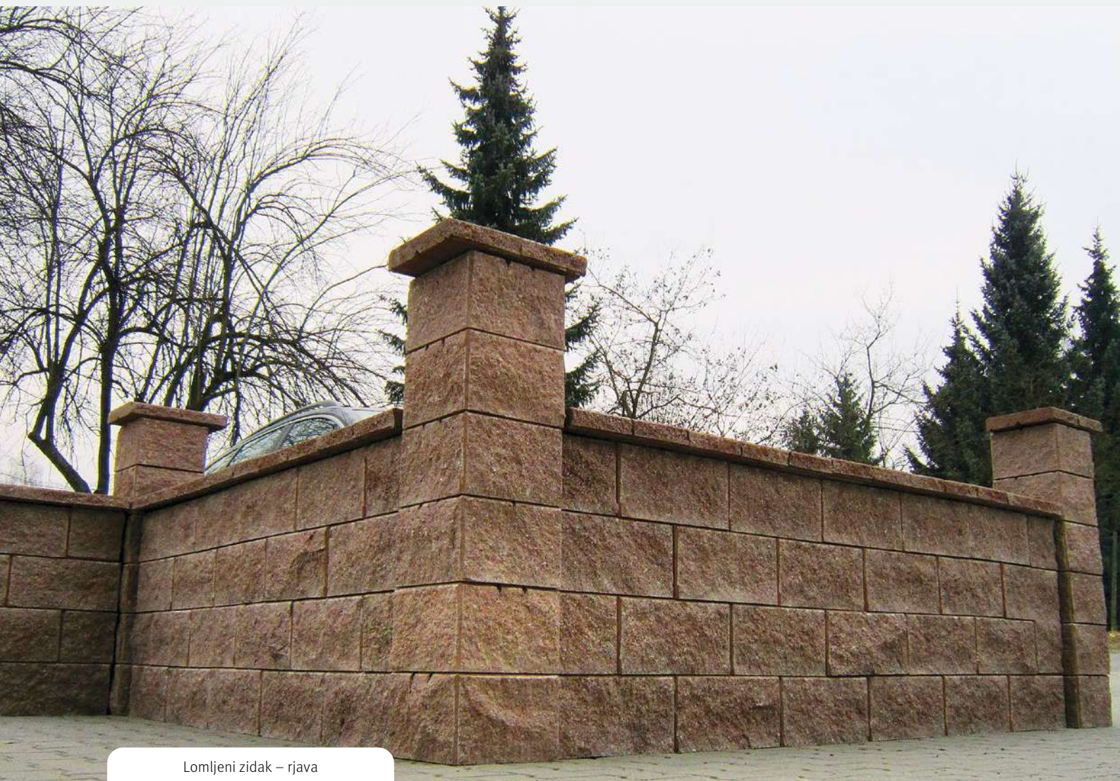
Lomljeni zidak – sivo-črna
